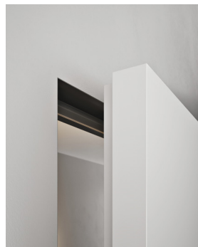
ZÁRUBEŇ S NADPRAŽÍM V PŘÍČCE
